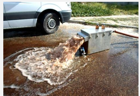
Durante a limpeza Conduta DN250/200
