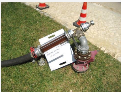
Durante a limpeza Conduta DN315/250
